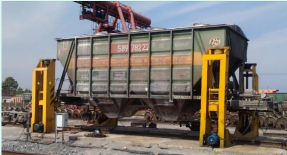
Участок текущего отцепочного ремонта грузовых вагонов
